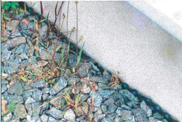
Abbildung 4: Bereich groben Schotters inkl. Lückensystem zwischen Hauswand und Schutzplane im südlichen Bereich an der Westfassade des bestehenden Gebäudes
