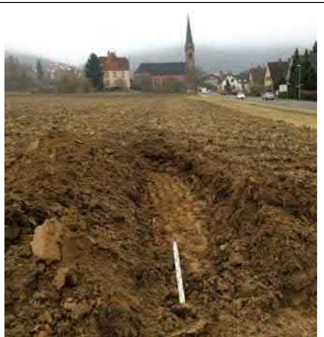
Foto 2: Schurf R13 Fläche Typ 2, lokal Bauschutt unter Oberboden (Foto: Binninger, 26.01.2022)
