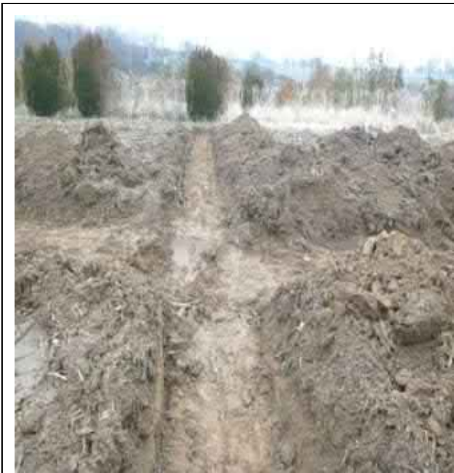
Foto 1: Schurf R13 Fläche Typ 2, lokal Bauschutt unter Oberboden (Foto: Buck, 26.01.2022)
