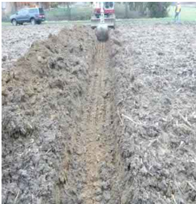
Foto 1: Schurf R11 Mutterboden über anstehender Decklage Fläche Typ1 – keine Auffüllung festgestellt (Foto: Buck, 26.01.2022)
