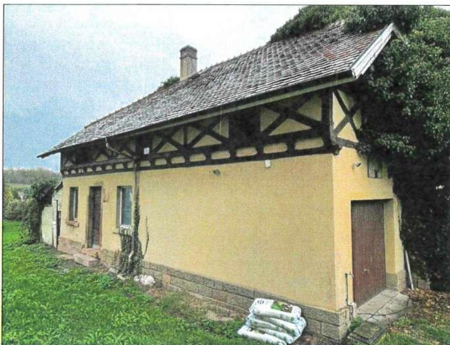
Bild 34: Nebengebäude mit Pkw-Garageneinbau, Südwestseite
