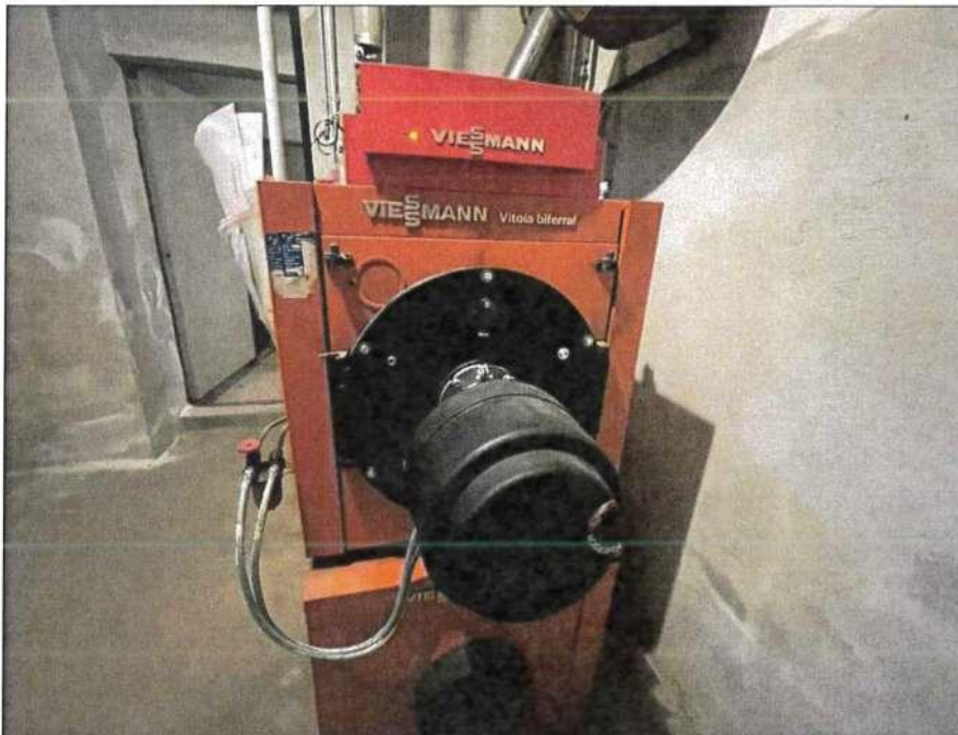
Bild 31: KG, Öl-Zentralheizung
