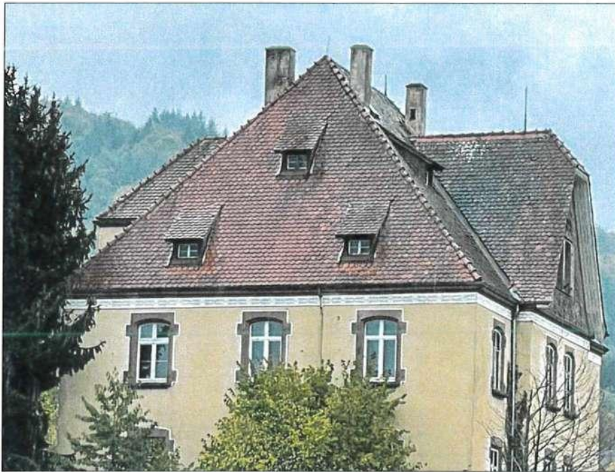
Bild 5: Walmdach mit Dachgauben, Ansicht von Westen
